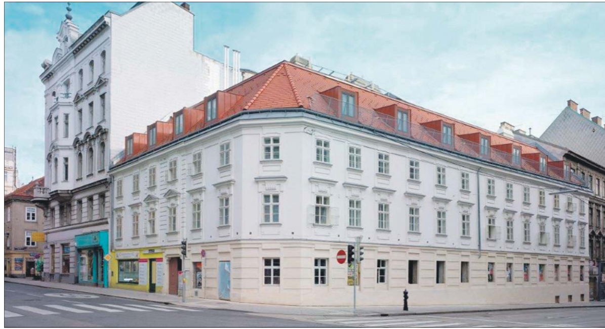
Ecke Gumpendorferstraße/Hofmühlgasse: Das Wohnhaus „Zum Auge Gottes“ wird gerade saniert.
