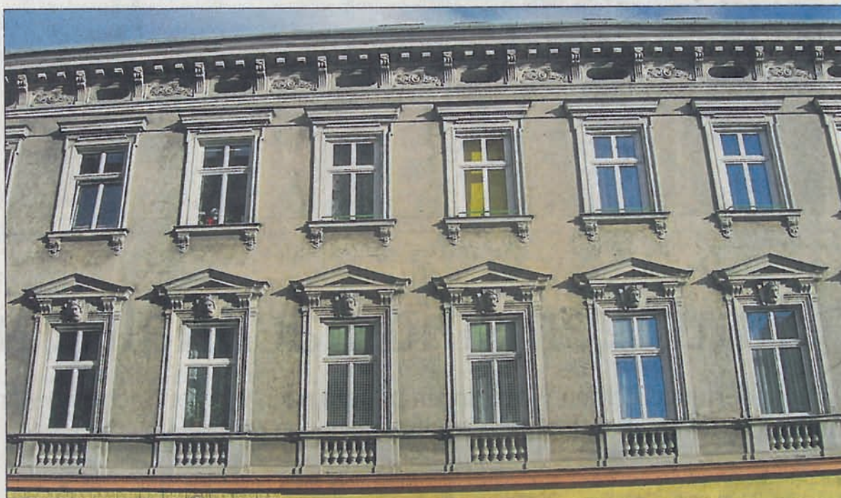
Vorher: typisches Gründerzeithaus in der Vorstadt, wird derzeit saniert und ausgebaut.
