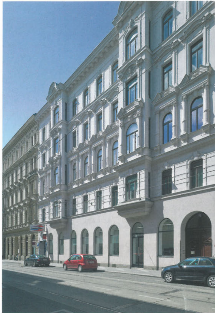
Das Projekt in der Kaiserstraße ist eine Top-Investition.
